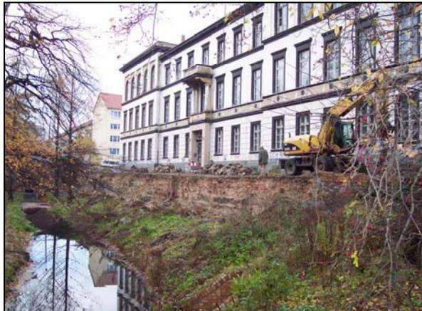
Die mit Fundament 6 m hohe und 70 m lange Stützwand aus Klinkern während des Abtrages
