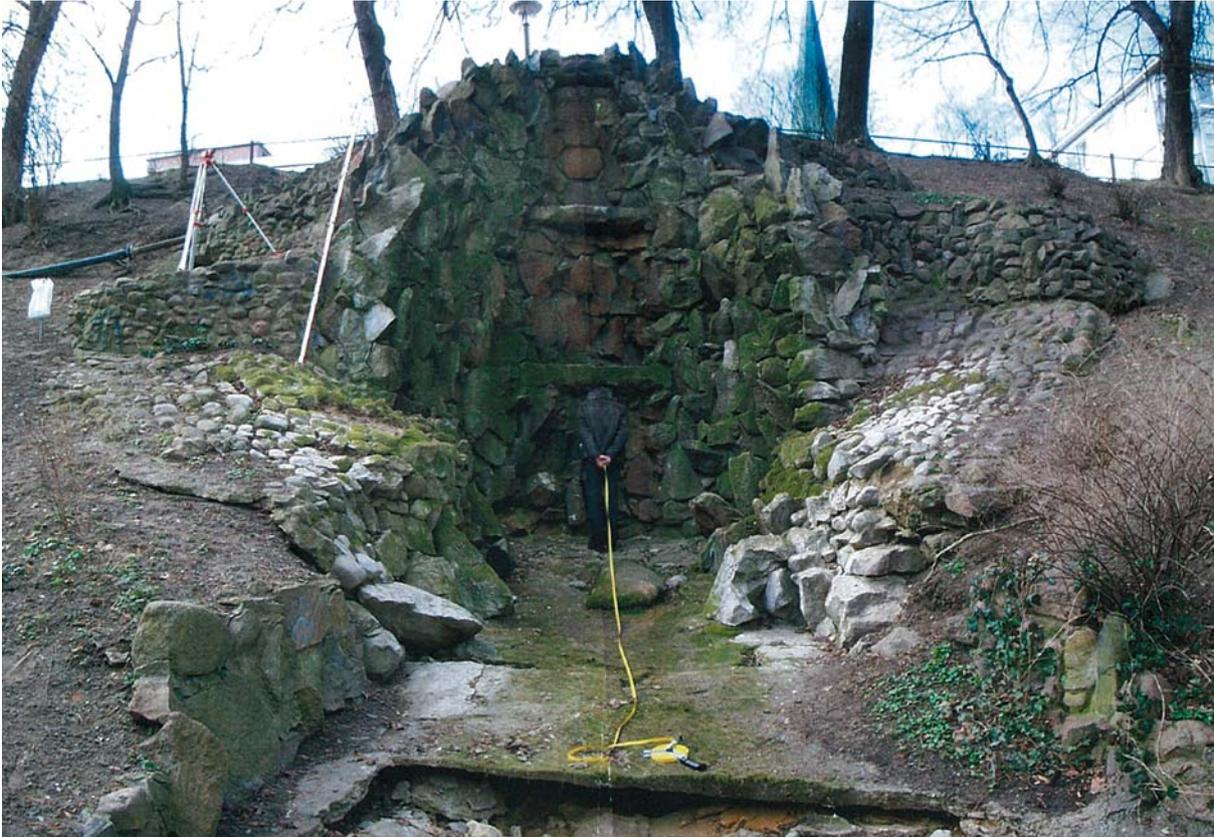
Kaskade 2009 vor der Sanierung mit den um 1900/1920 gesetzten, abbrechenden, den Hang stützenden Flügelmauern und einem nicht mehr vorhandenen Wasser-Abflusskanal mit aufgelösten seitlichen Fassungen.
