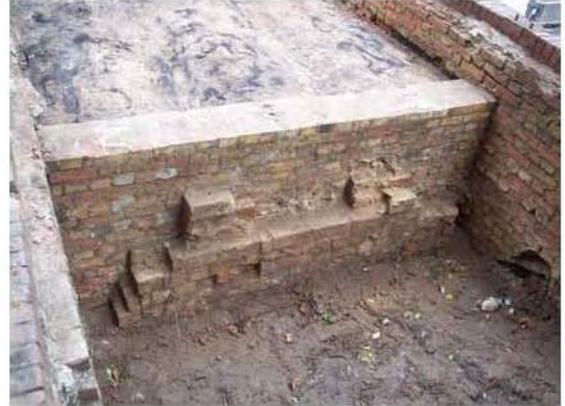
**Abb. 2** Widerlager Hauptgewölbe und Stirnwand der westlichen Stützgewölbe
