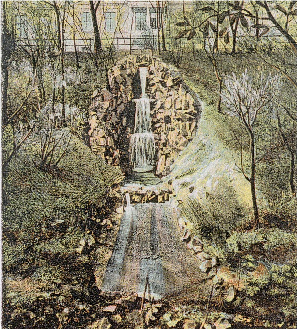
Kaskade um 1890 in künstlerischer Fassung einer Postkarte. Der Kaskadenmantel ohne die den Hang stützenden Flügelmauern, der Abflusskanal bereits desolat
